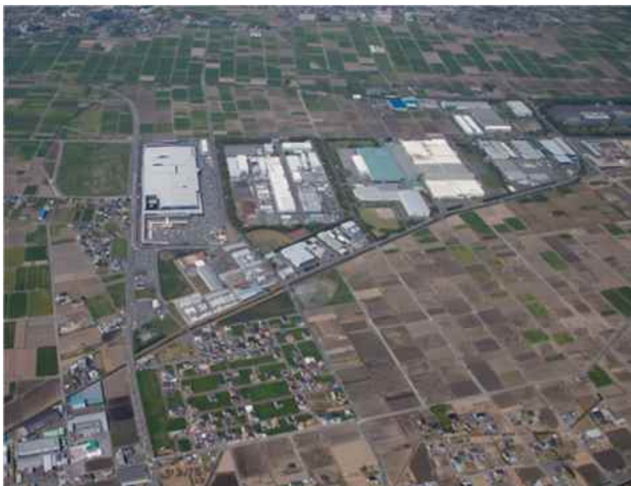
造成工事の進む千代田工業団地周辺
