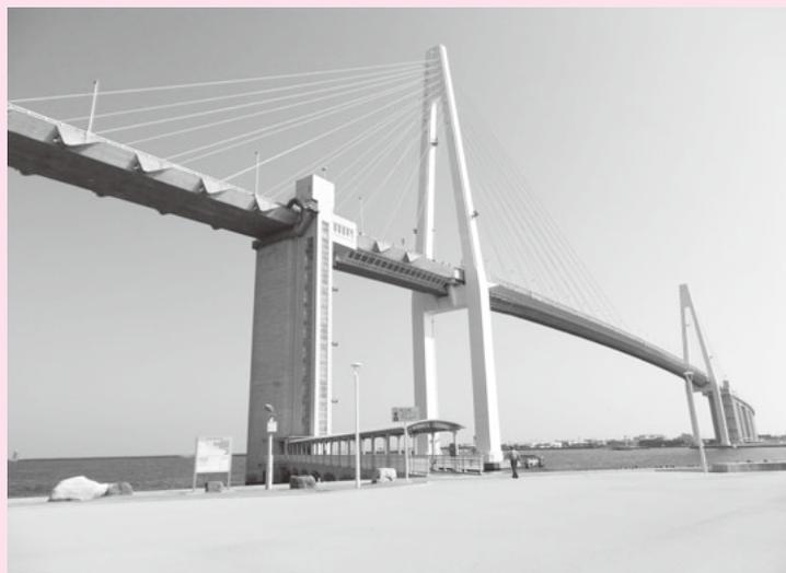
新湊大橋は射水市の富山湾に架かる日本海最大級の斜張橋で、県営の渡船を利用する以外手段がなく、50年間も分断されていた地域間の交流や絆を取り戻す地域住民の悲願として、平成25年に全線開通しました。全長3.6km、総工費は約494億円、上層は車道、下層は歩行者専用道路であり、歩行者はエレベーターで上下移動しています。
