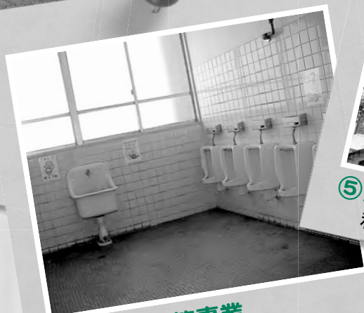
⑤ 施設改修等事業 老朽化したトイレの改修工事
