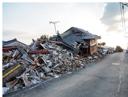
写真：熊本地震による家屋倒壊
