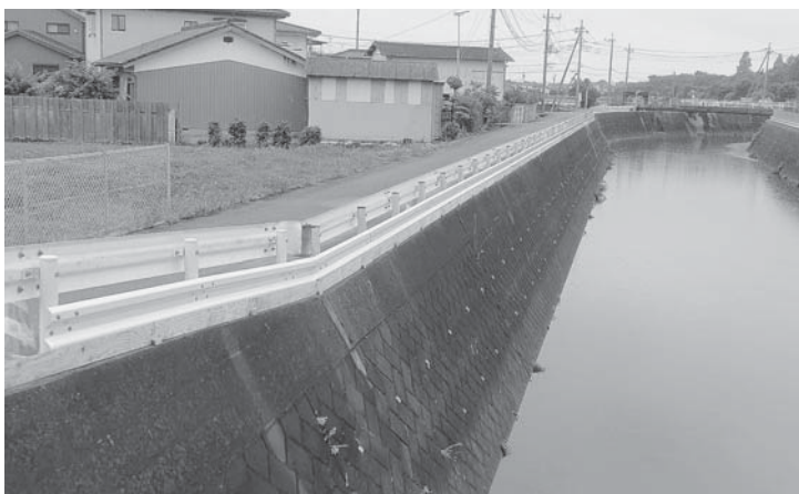
遮水壁の工事が進む新谷田川放水路（中島地内）
