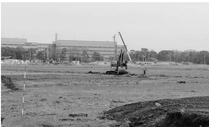
造成工事が進む第二工業団地
