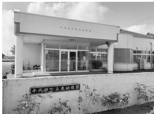
使われなくなった旧東幼稚園舎
