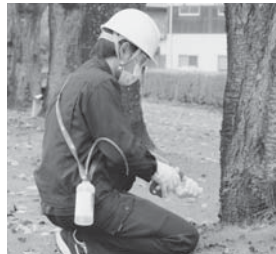
薬剤を樹幹注入の様子
