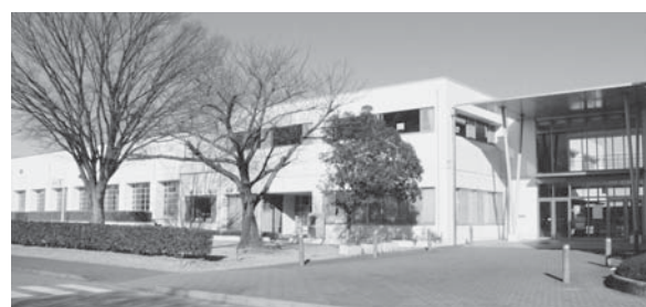
屋上の修理が予定されている温水プール小体育館
