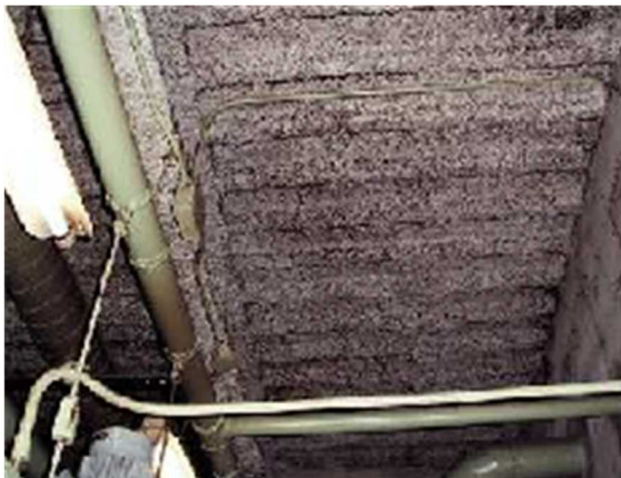
石綿含有吹付けロックウール
