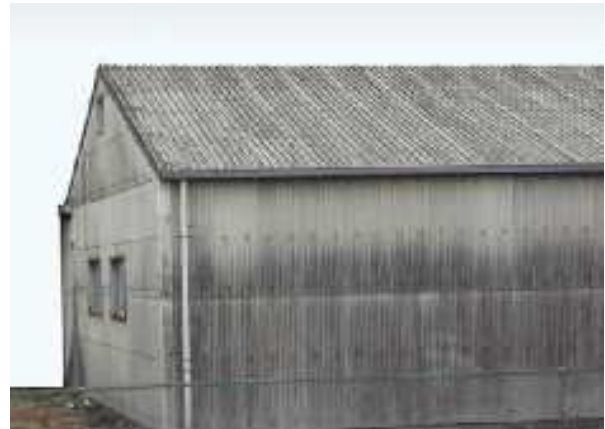
石綿含有スレート波板（屋根・外壁）
