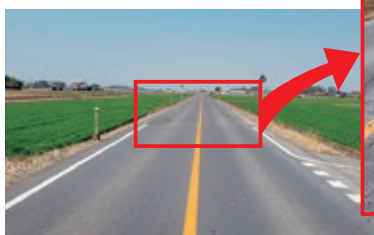
舗装工事で快適性向上
