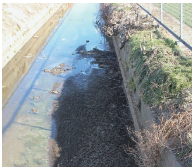
除去作業が難しい深い水路（雑草・汚泥）
