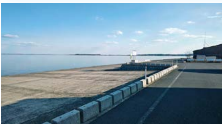
整備されている大山スロープ
