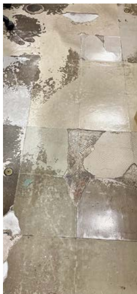
傷んだ床、修繕へ
