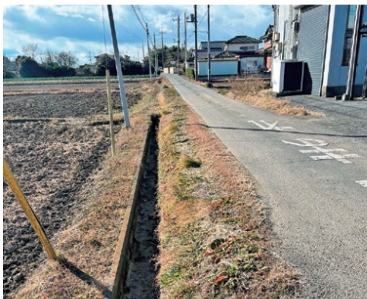
整備予定の福島地内町道
