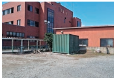
発電機の整備予定地
