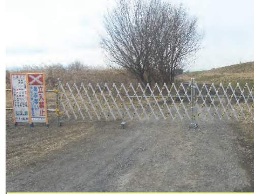
車両進入防止バリケードの設置
