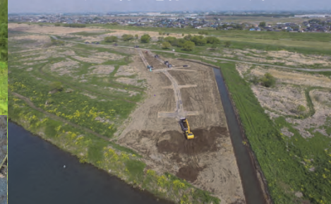
河川敷を掘削し、治水安全性の向上と湿地再生を行っています。
