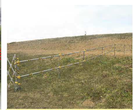
堤防法面への立入防止柵の設置
