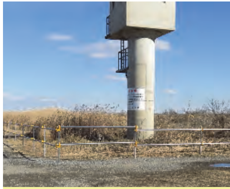
立入防止柵の設置
