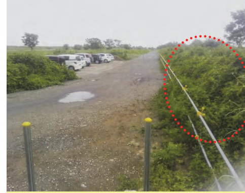
侵入を防止する盛土の整備
