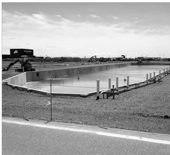
造成が進む商業用地
