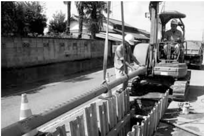
上水道の老朽管布設替え
