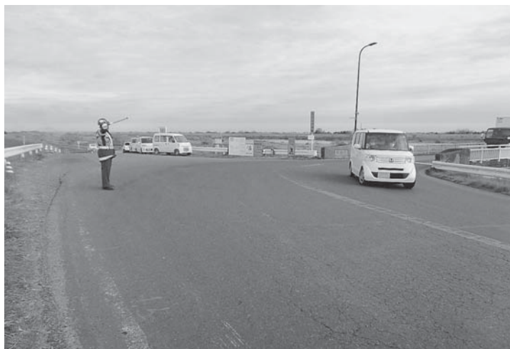
道路拡幅工事が行われる利根大堰付近
