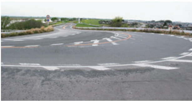
道路拡幅工事された利根大堰
