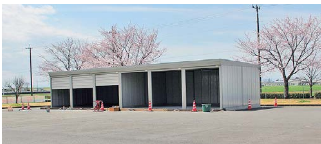
建設中のちよだecoパーク東
