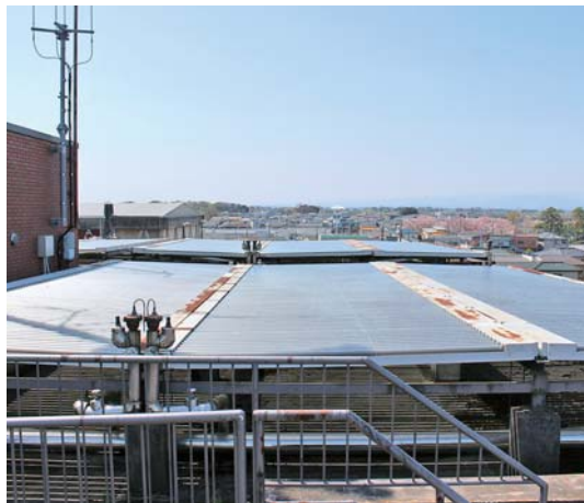
現在使われていない屋上設備
