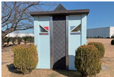
シンワコンストラクションくらかげ公園(上) SEKIGUTI昭和公園(下)のトイレ
